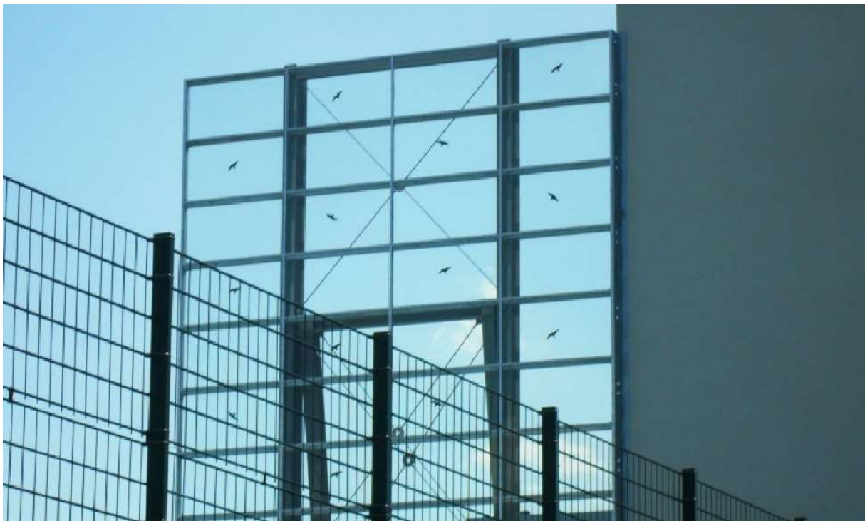
Abb. 8: Greifvogelsilhouetten wirken für Vögel wie ein schwarzer Fleck. Sie weichen diesen ein paar Zentimeter aus und prallen trotzdem gegen die Scheibe. In der Regel deuten die Silhouetten darauf hin, dass es regelmäßig zu Vogelkollisionen kommt und die Problematik somit grundsätzlich erkannt worden ist. (H. Gruppe)
