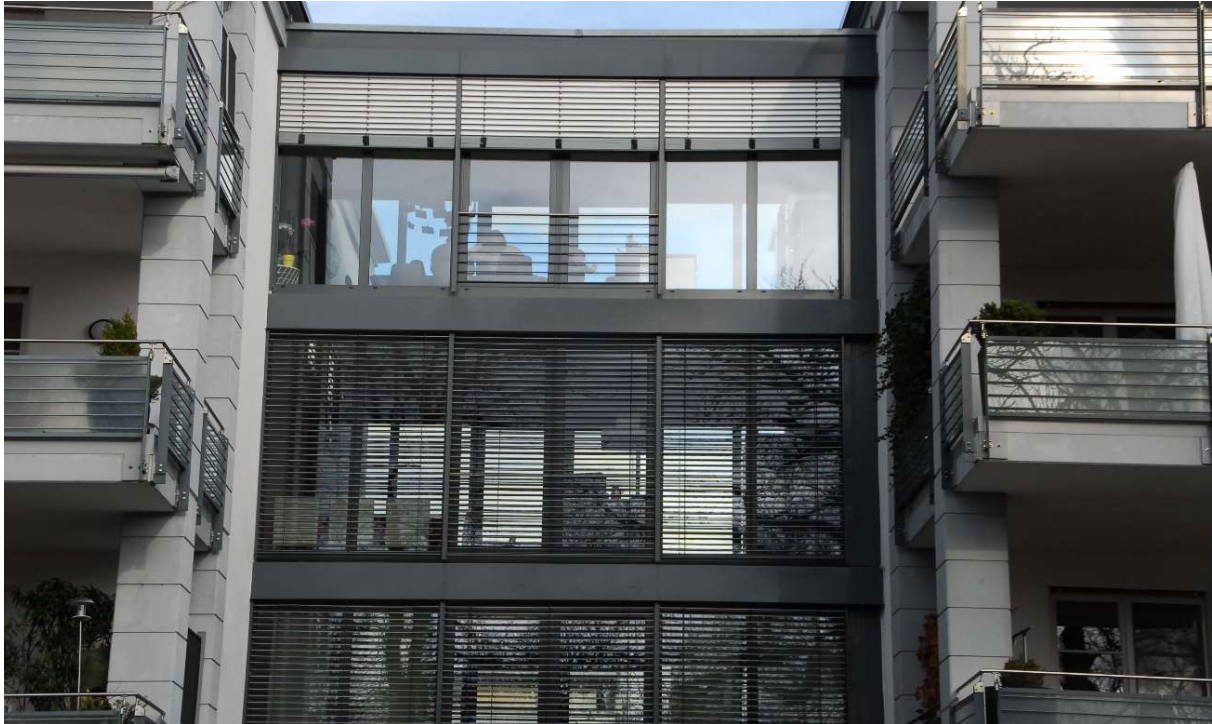
Abb. 6: Jalousien verhindern Vogelschlag, wenn sie dauerhaft heruntergelassen sind. Das ist aber nicht immer zuverlässig gewährleistet (B.-U. Rudolph)
