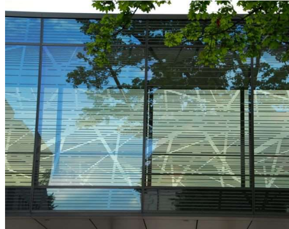
Abb. 4: Für Mensch und Vogel wirksam markierter Übergang zwischen zwei Gebäuden eines Krankenhauses (B.-U. Rudolph)
