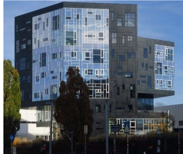
Abb. 15: Zusammen mit den Glaseigenschaften beeinflusst auch der Lichteinfall Spiegeleffekte (B.-U. Rudolph).
