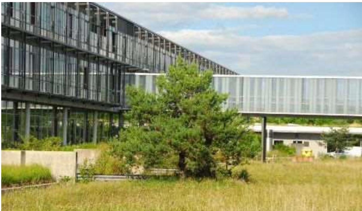
Abb. 21: Übergang zwischen zwei Flügeln eines Verwaltungsgebäudes mit vogelsicheren, matten Scheiben (B.-U. Rudolph)
