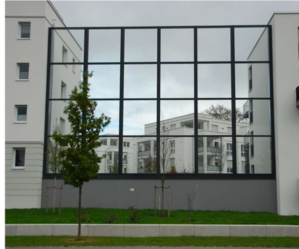
Abb. 12: Hohe transparente Trenn- und Lärmschutzwand an einem Gebäudekomplex. Vogelschlag ist hier wiederholt nachgewiesen (B.-U. Rudolph)
