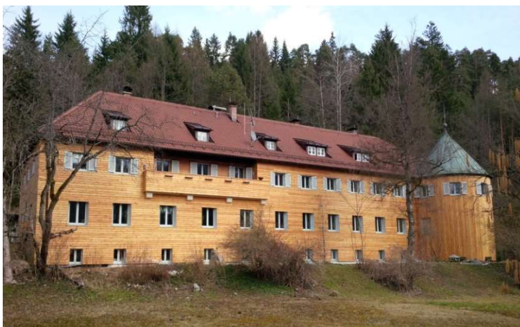
Garmisch-Partenkirchen, Staatliche Vogelschutzwarte (B.-U. Rudolph)
