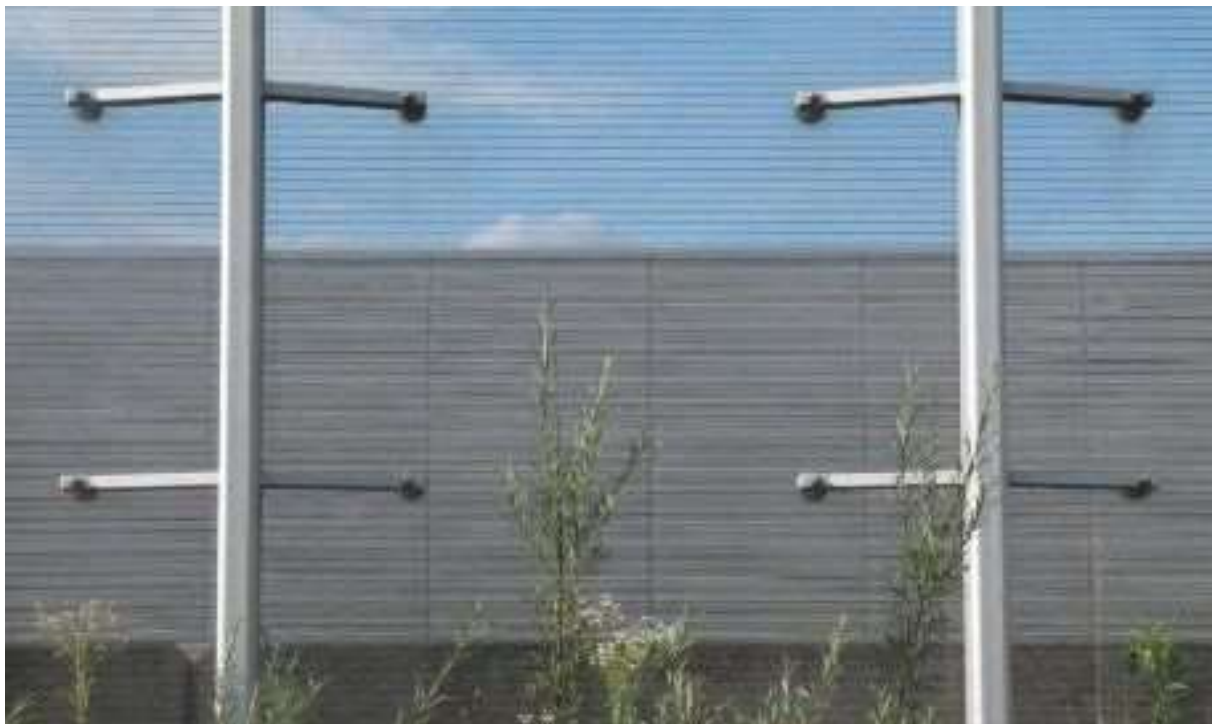
Abb. 5: Als wirksam gestestete Streifenmarkierung an einer Lärmschutzwand (B.-U. Rudolph)
