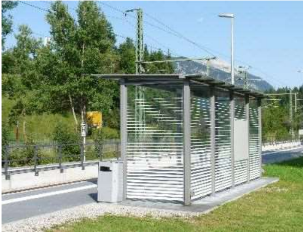
Abb. 3: Fahrgastunterstand der Deutschen Bahn mit charakteristischer Streifenmarkierung (J. Bellebaum)
