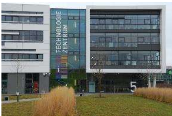
Abb. 19: Fassaden moderner Gebäude weisen häufig sehr unterschiedliche Glasanteile und Glaseigenschaften auf (B.-U. Rudolph)
